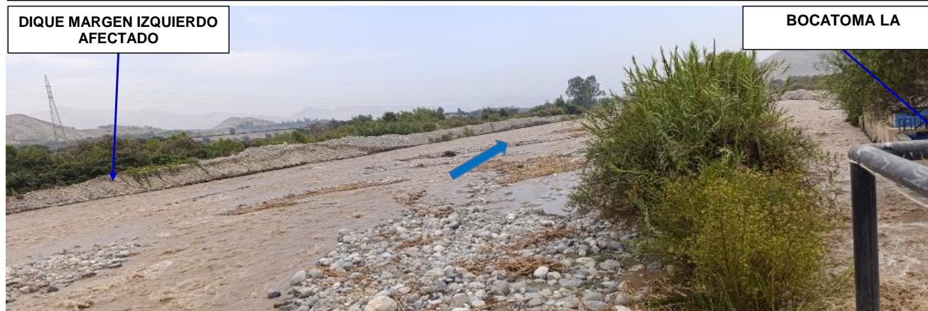
FIGURA N°02: RIO CHANCAY-HUARAL, AGUAS ABAJO DE LA BOCATOMA LA ESPERANZA CON DIQUES EROSIONADOS EN AMBAS MARGENES E ISLAS DE SEDIMENTO EN EL CAUCE DE RIO.
