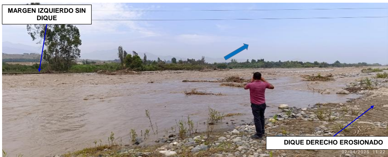
FIGURA N°03: RIO CHANCAY-HUARAL, MARGEN IZQUIERDA SECTOR SANTA ROSA SIN DIQUE, EROSIONADO POR EL CAUDAL Y LA MARGEN DERECHA SECTOR EL TRES CON EL DIQUE EROSIONADO Y POR DETRAS SE ENCUENTRA ÁREAS DE CULTIVOS DE FRUTALES EN AMBOS LADOS.
